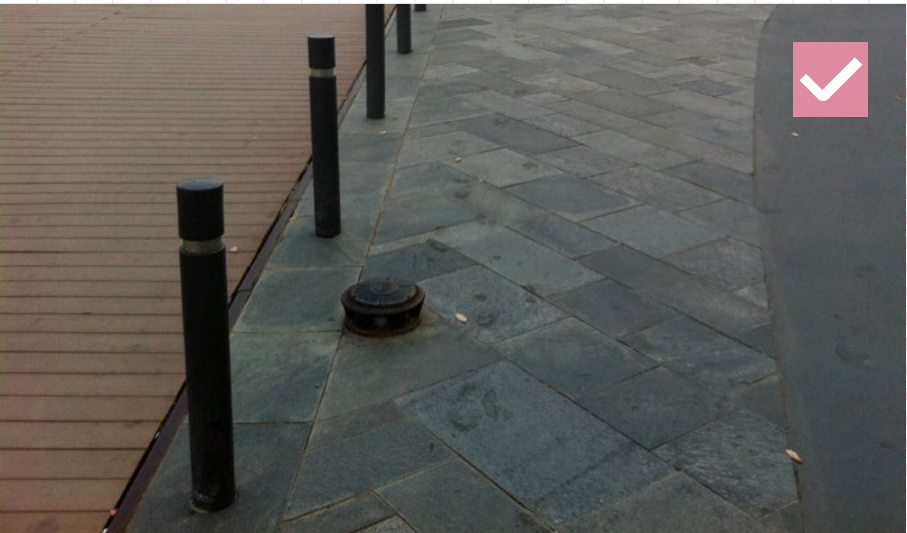
20 Príklad vhodného detailu v prípade podpovrchového kotvenia stěpíka do dlažby väčšieho formátu. Do veľkoformátovej dlažby je vhodné otvor vyrezať. Barcelona
