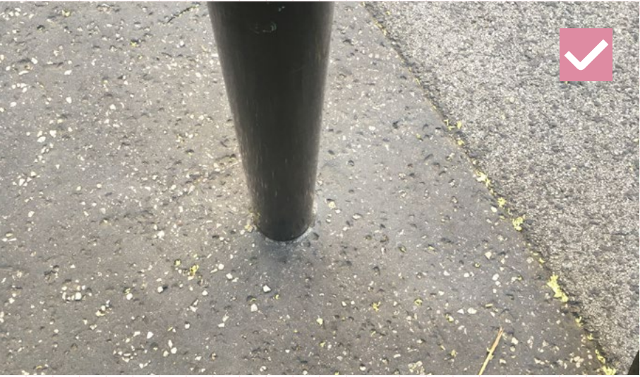
22 Príklad vhodného detailu v prípade podpovrchového kotvenia stěpíka do asfaltu. Treba klásť dôraz na to, aby asfalt bol v jednej rovine dotiahnutý až k stěpíku. Tiež je dôležité vyhnúť sa nepekným detailom, ktoré vznikajú vyplňaním okolia stěpíka cementom a inými materiálmi. Bratislava
