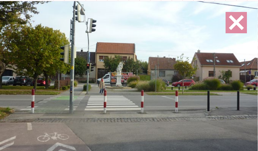
26 Nevhodný príklad umiestnenia stĺpikov v prípade kombinácie priechodu pre chodcov a priechodu pre cyklistov. Stĺpik je nevhodne umiestnený mimo osi cyklopriechodu. Stĺpiky by mali byť umiestnené mimo cyklotrasy (resp. v prípade širších cyklotrás v strede priechodu vždy na okraji jazdného pásu). Farebné červeno-biele riešenie stĺpikov sa neodporúča. Bratislava, Roľnícka ulica
