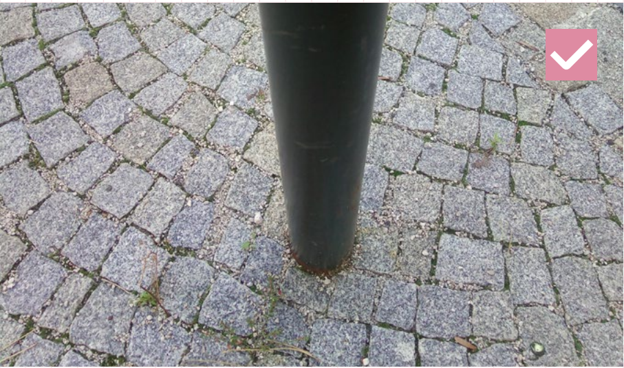
21 Príklad vhodného detailu v prípade podpovrchového kotvenia do dlažby malého formátu. Bratislava, Svoradova ulica
