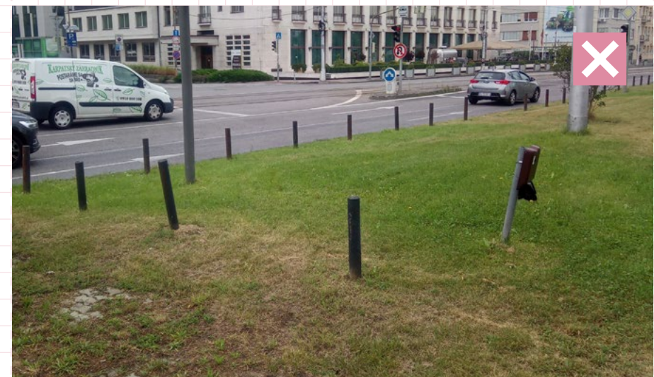
11 Nevhodný príklad výšky stĺpikov – príliš nízke stĺpiky môžu byť ľahko prehliadnuteľné pre peších, ale tiež z vozidiel. Vo všeobecnosti osádzať stĺpiky do zelene je neprípustné. Bratislava, Rázusovo nábrežie
